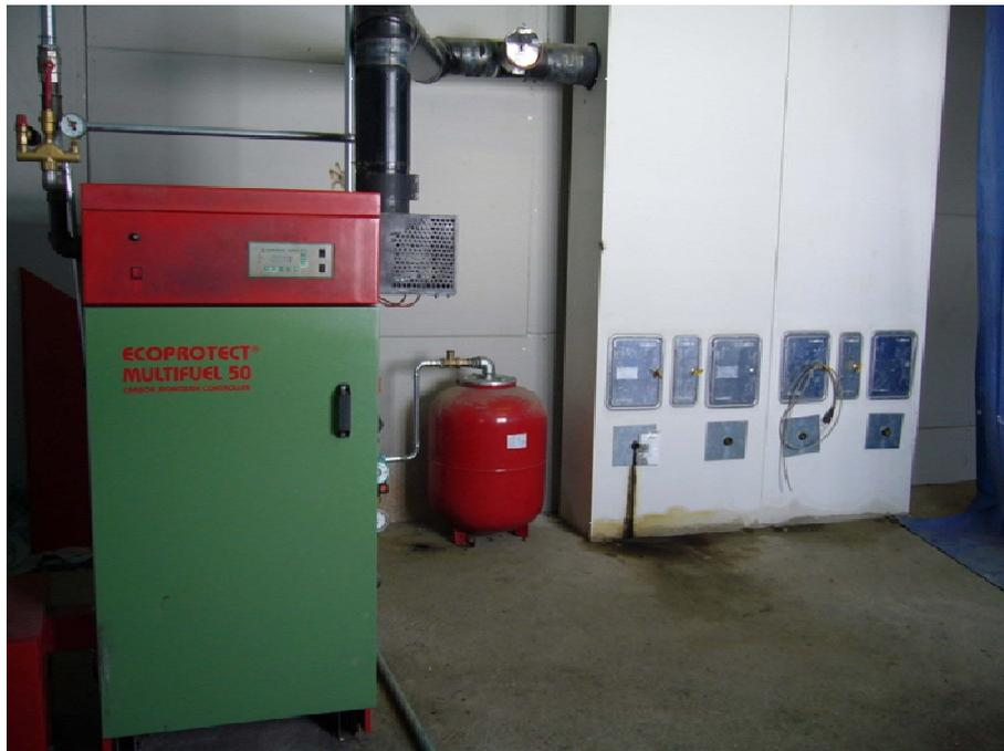
Abbildung 2-1: Feuerungsanlage zur Verbrennung von Heupellets
